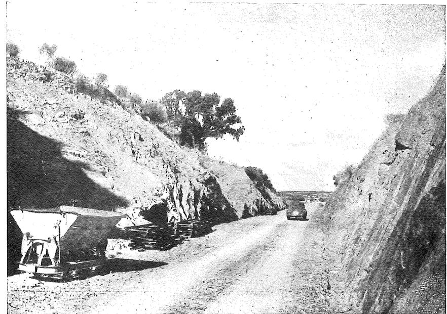
Fig. 2.—Gran trinchera del ferrocarril en construcción en pizarra cambriana potsdamiense atravesado por masas y diques de diabasas y rocas diorítico-gábricas, en las inmediaciones del caserío de El Lavadero. El pizarra se arrumba a los 80° buzando septentrionalmente de 65 a 75°. Vista al Este (Fot. X-56.)
